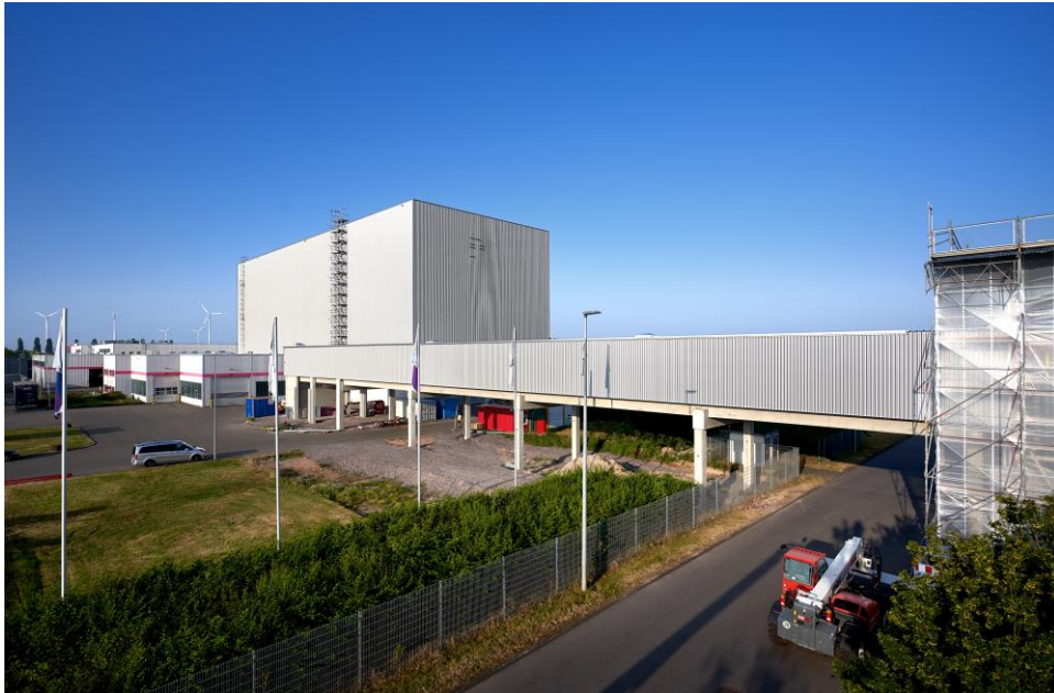
Das erweiterte Hochregallager und die neue Transportbrücke
