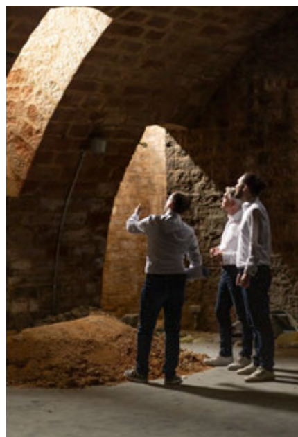
In uno spazio dedicato all'epoca alla cantina dei vini sorge ora uno straordinario locale con soffitto a volta destinato agli eventi
